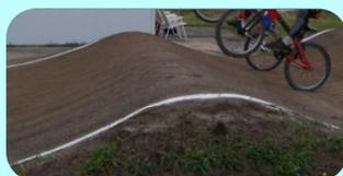
Cet obstacle ne doit pas être considéré comme un saut mais plutôt un obstacle sur lequel il est possible de gagner de la vitesse. Ils peuvent être placés dans des sections rapides ou plus lentes. Les rouleaux doivent être ronds sans aucune pointe distinctive.
