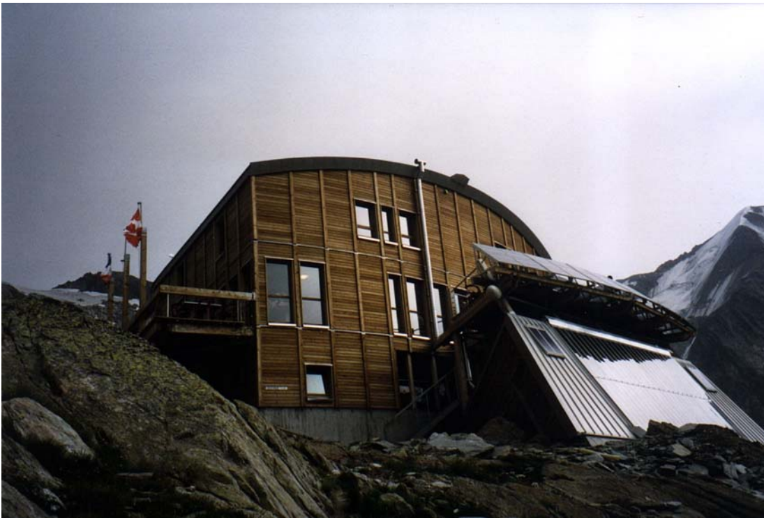
La génération des refuges « high tech » : quand les architectes se font plaisir... Qu'en pensent les utilisateurs ? (refuge des Conscrits, CAF, massif du Mont-Blanc)
