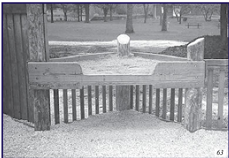
*Le bord de ce bac à sable surélevé a été conçu de sorte à fournir l'accès au moyen d'une ouverture dont les proportions sont généreuses. Le haut des bords, les bordures, ou d'autres obstacles pouvant bloquer l'accès à une surface de table devrait être d'une hauteur maximale de 787 mm (31,0 po).*
