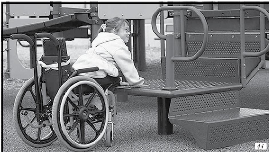
Là où un système de transfert est fourni, l'ensemble de plateformes de transfert et de marches de transfert offre une voie accessible continue menant aux composantes de jeu surélevées. Un système de transfert fournit aux individus l'espace nécessaire pour se transférer physiquement vers le haut ou le bas d'une structure de jeu composée. Lorsqu'il est fourni, une largeur minimale de 610 mm (24 po) est requise pour le déplacement des individus autour d'une structure.
