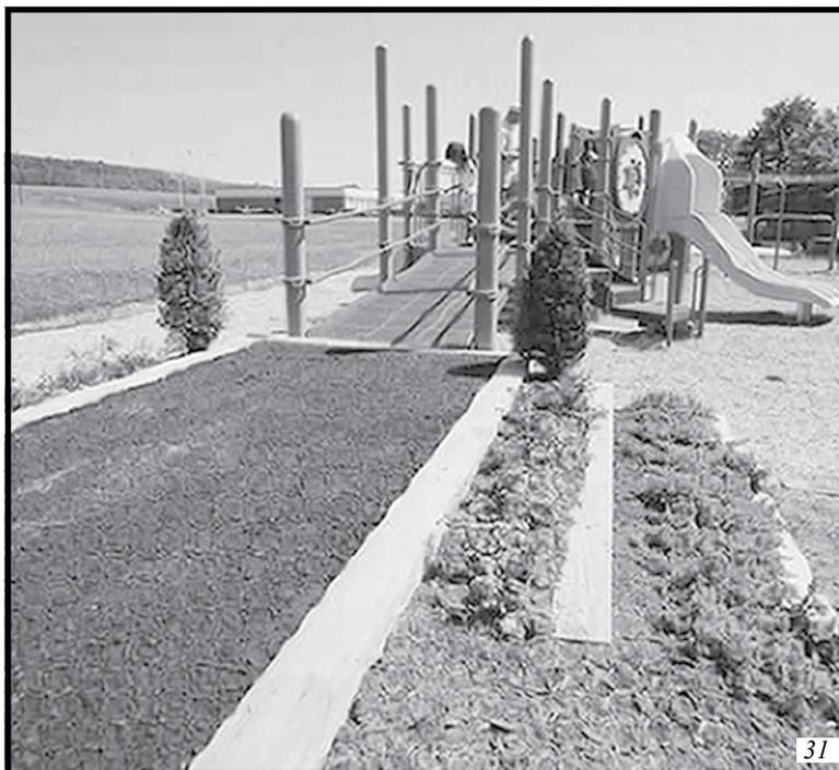
*Pour accommoder un changement d'élévation le long du périmètre d'une aire de jeu - comme ces tuiles en caoutchouc placées sur une surface d'asphalte - une pente permmissible de 1:12 est utilisée pour la transition avec le périmètre de l'aire de jeu.*
