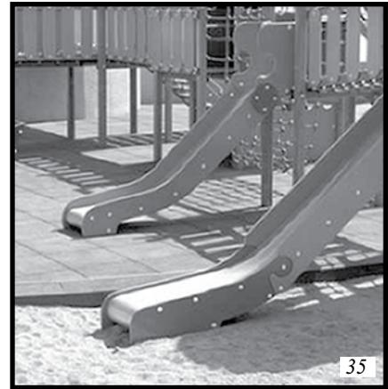
Les surfaces au sol devraient être inspectées et entretenues périodiquement et fréquemment afin d'assurer qu'elles demeurent conformes à la norme ASTM 1951 et dans le cas des zones munies de surface de protection, la norme CAN/CSA-Z614, Clause 10.
