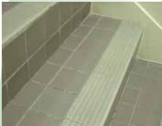
Les marches sont sécuritaires grâce aux bandes antidérapantes et de couleurs contrastantes.
