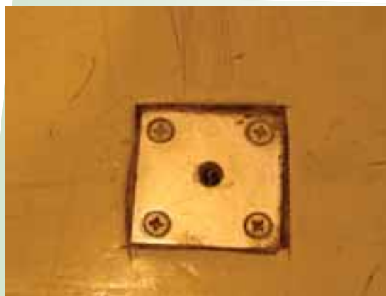
Ancrage avec vis : le filet permettant de visser a tendance à s'encrasser. Le système qui sert à amarrer le but au sol devient inefficace.
