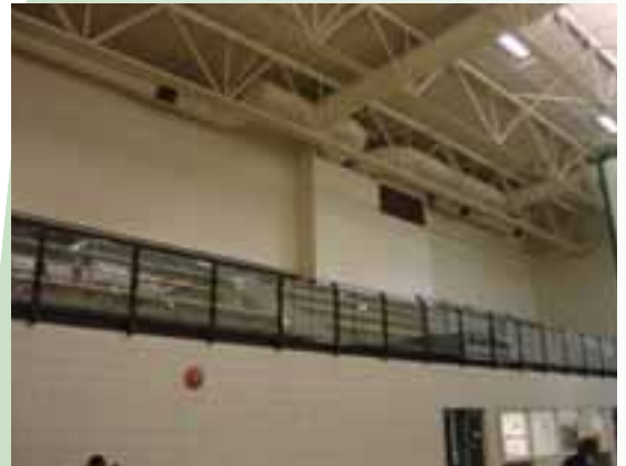
Avec une paroi en verre trempé, la balustrade est sécuritaire. Les spectatrices et les spectateurs ont, en prime, une meilleure vue sur le terrain de sport.
