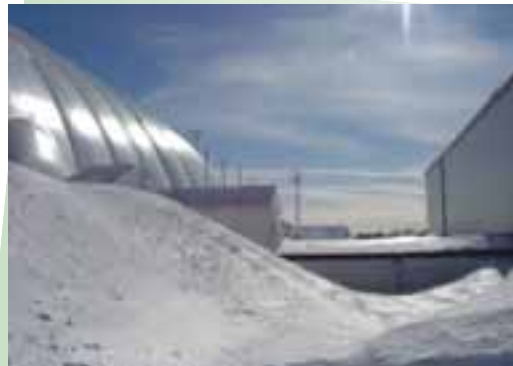
La gestion de la neige doit être prise en considération dans l'exploitation d'une structure gonflable.
