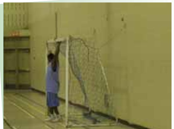
Ce but est sécurisé par un ancrage au sol et une fixation murale.
