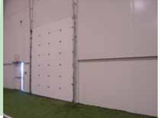
Une porte de garage donnant directement vers l'extérieur facilite l'accès de la machinerie pour l'entretien de la surface ou encore pour la livraison des chaises, des tables ou des estrades.
