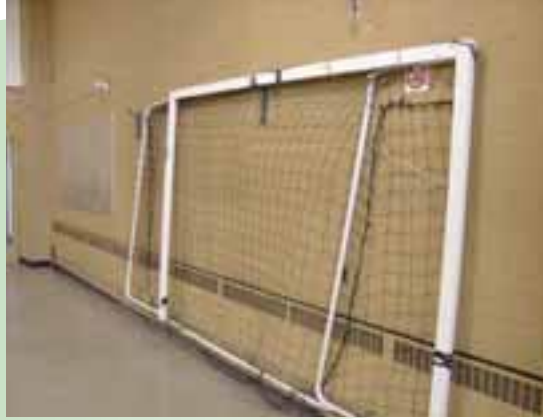
Le but est plié et fixé à l'aide d'un support sur le mur du gymnase.
