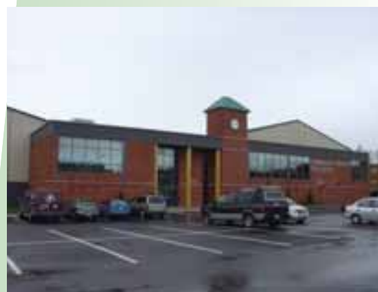
Il est toujours possible d'offrir une façade assurant une meilleure intégration à l'environnement. Reste maintenant à récupérer l'eau de pluie du stationnement.
