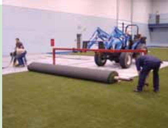
Les opérations de montage et de démontage de la surface peuvent prendre plusieurs jours. Ce complexe est utilisé en période estivale pour des foires agricoles. Le tapis est retiré.
