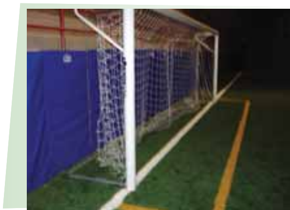
La marge entre la ligne de jeu et le mur est insuffisante.
