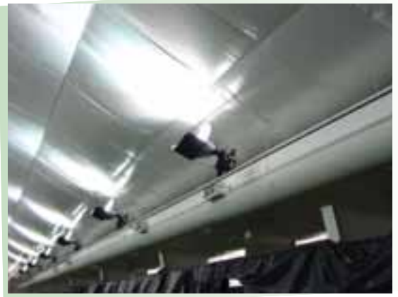
L'éclairage indirect du plafond n'éblouira pas les joueuses et les joueurs. Le plafond est conçu avec des matériaux réfléchissants.
