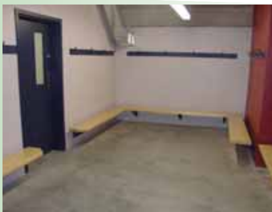
Ces vestiaires adéquats sont conçus pour durer et sont faciles à entretenir.
