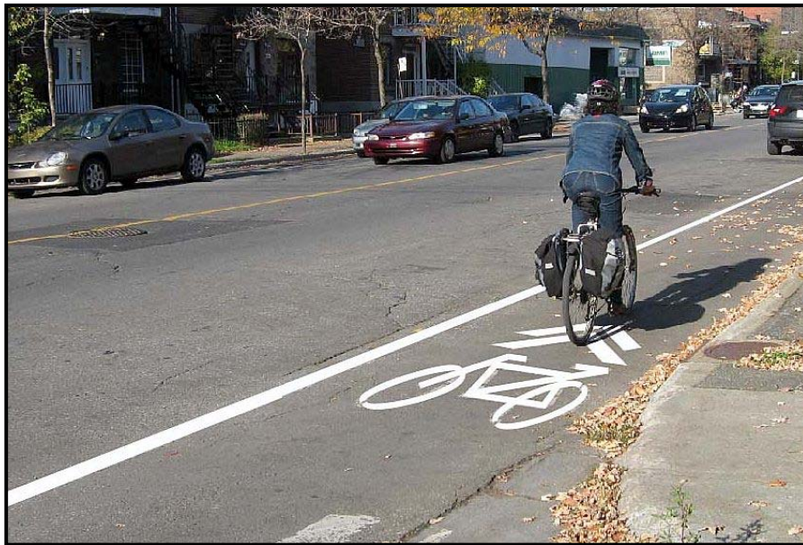
Figure 3 : Bande cyclable unidirectionnelle avec marquage au sol
