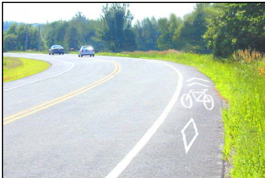
Figure 2 : Accotement revêtu (asphalté)
