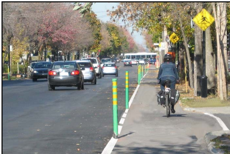
Figure 4 : Bande cyclable unidirectionnelle avec délinéateurs
